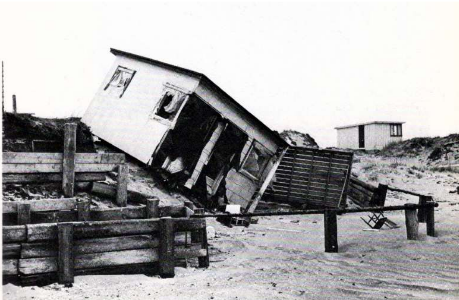
Foto 14 Huset har underminerats av vågerosion. Skrea Strand.
