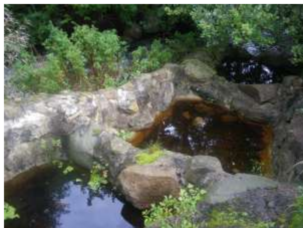
Tidigare anlagd fiskväg som är satt ur funktion
